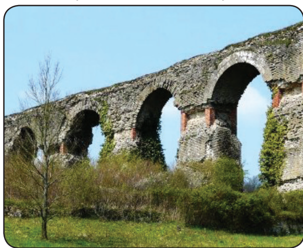
Restauration aqueduc gallo-romain d'Ars-sur Moselle - 2014 © Anthony Koenig
