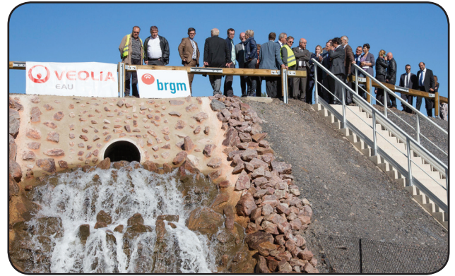
Station de pompage et de traitement des eaux minières Vouters à Freyming-Merlebach
