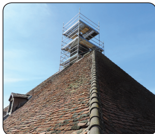
Réfection de la toiture de l'Hôtel de ville de Phalsbourg - 2014 © Mairie de Phalsbourg
